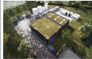
Unité d'effluents du programme Jourdan © Aster PVL, Architectes - Tours
